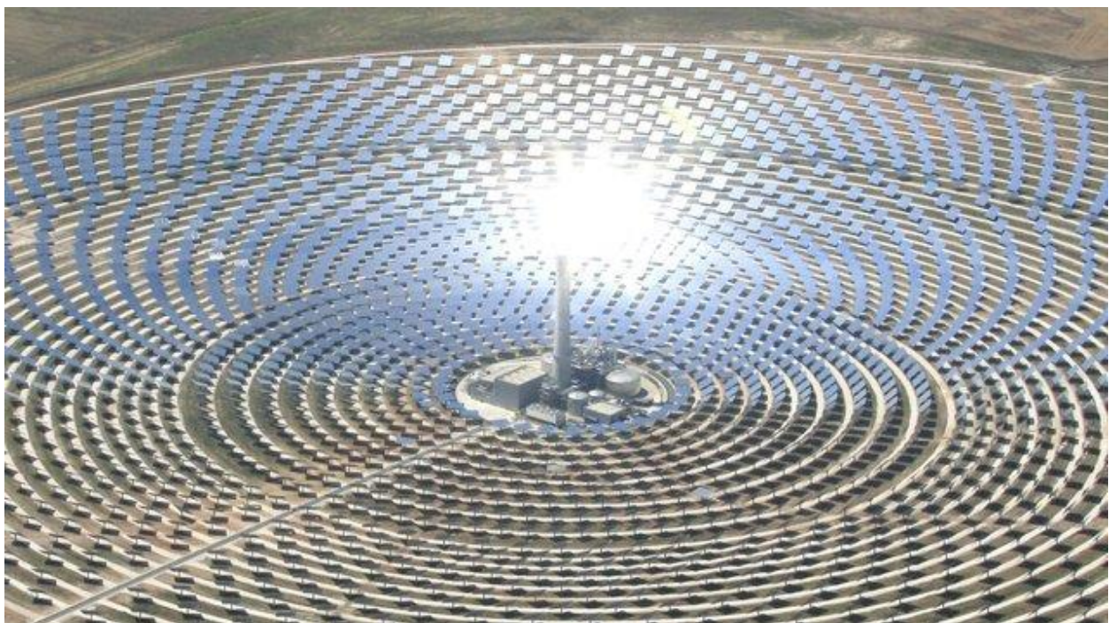
Figura 6.2. Planta termosolar mediante concentración puntual en torre, mediante campo de espejos
