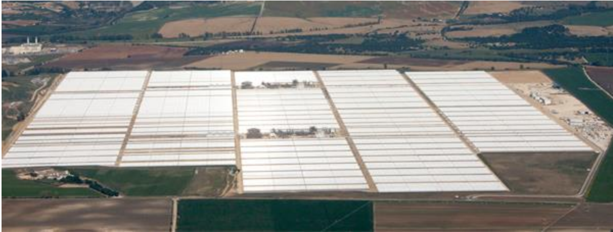
Figura 6.6. Planta termosolar de Valle 1 y 2.
