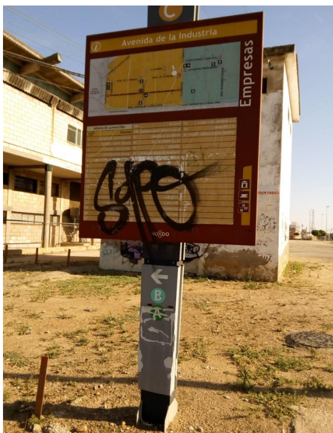
Figura 25. Señal en mal estado en el PICA.
