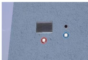
Figura 5-2 Sensor de brillo externo a activar
