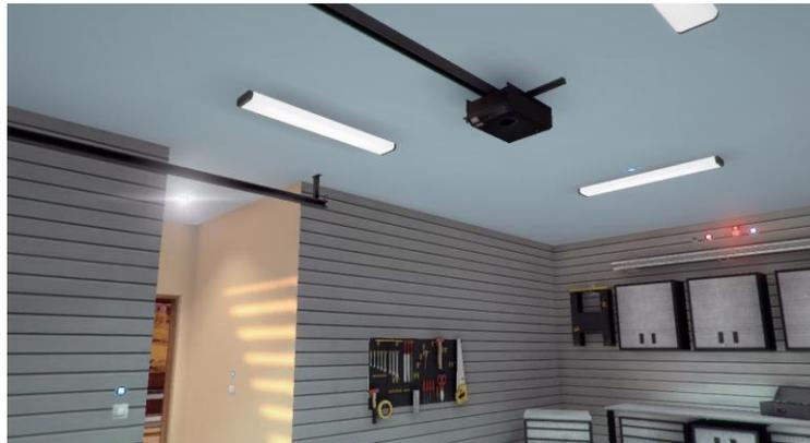
Figura 5-13 Motor de la puerta y sensores del garaje
