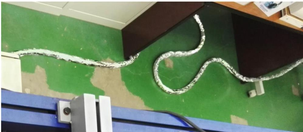
Figura 2-19. Cables protegidos contra las interferencias electromagnéticas.
