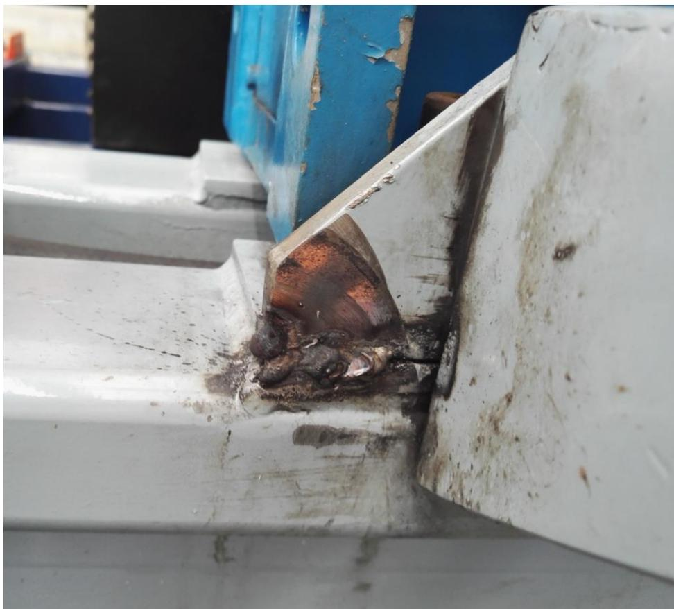
Figura 3-8. Nueva soldadura del lateral izquierdo.
