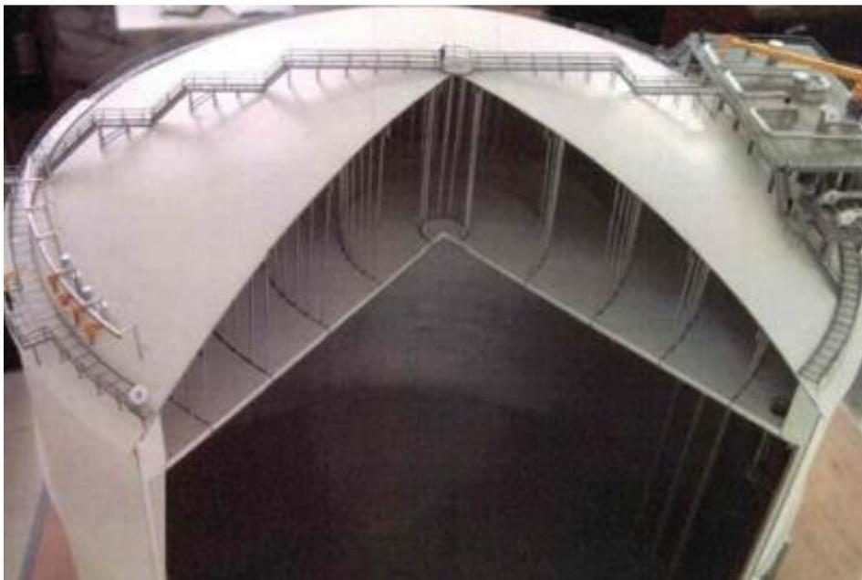
**Figura 12. Sección tanque - Techo suspendido [10]**
