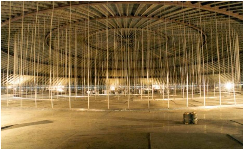
**Figura 11. Interior tanque - Techo suspendido [10]**
