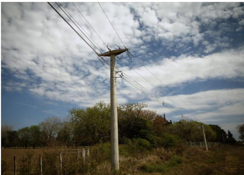
Figura 2-2. Circuito no compacto junto a circuito compacto en el mismo apoyo
