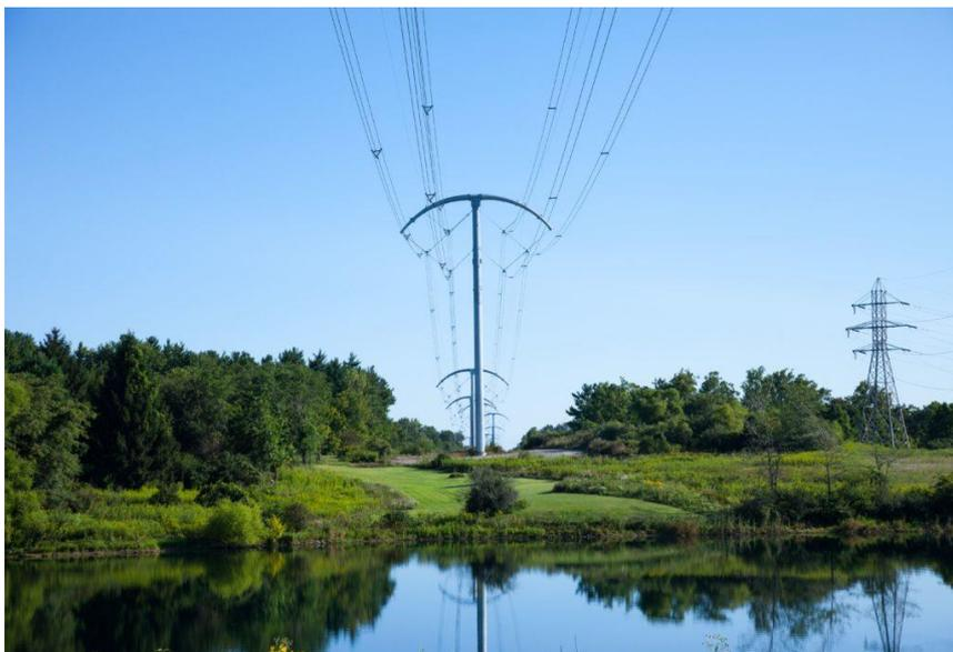
Figura 2-3. Línea compacta extra alta tensión con apoyos BOLD (138 kV y 345 kV)
