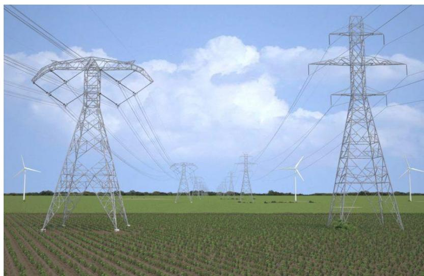
Figura 2-5. Sustitución línea 345 kV en Indiana por una compacta con apoyos BOLD
