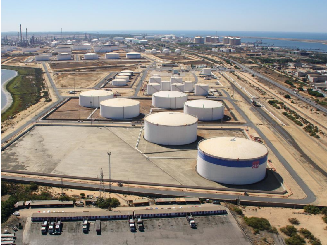
Imagen 4: Centro Logístico de Hidrocarburos, Huelva
