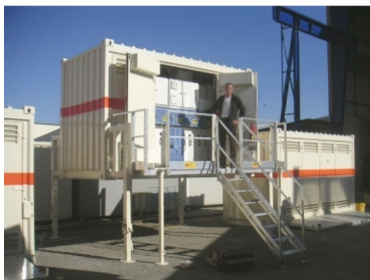
Figura 6-21. Centro de transformación de la gama CLIPPER M
