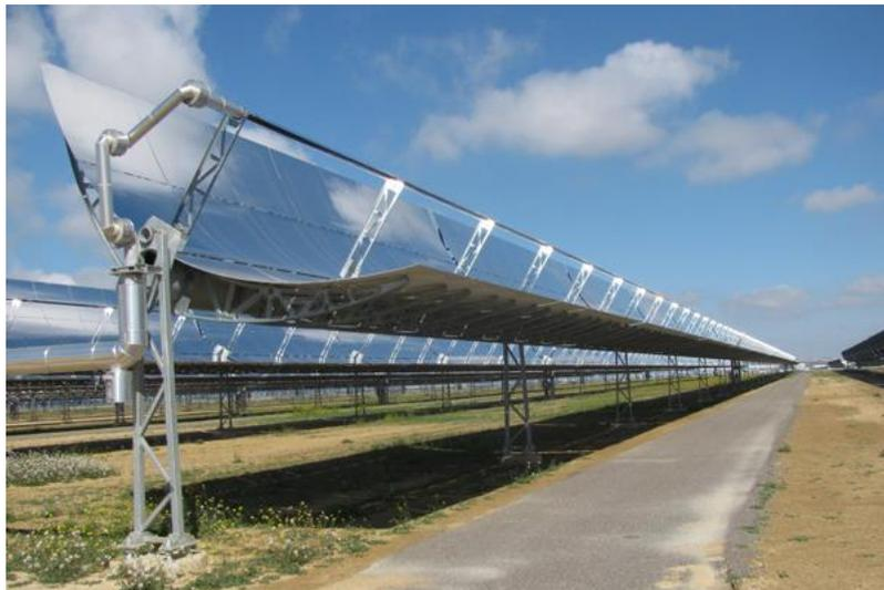
*Figura 11. Colector cilindro-parabólico, Solnova, Sanlúcar la Mayor, Sevilla (Abengoa Solar) [34].*
