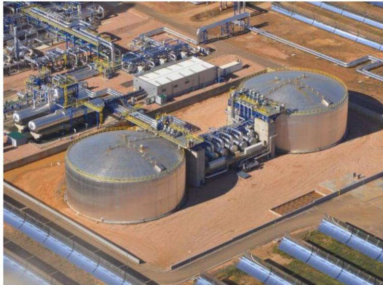
**Figura 13. Tanques de sales fundidas en una planta real [16].**
