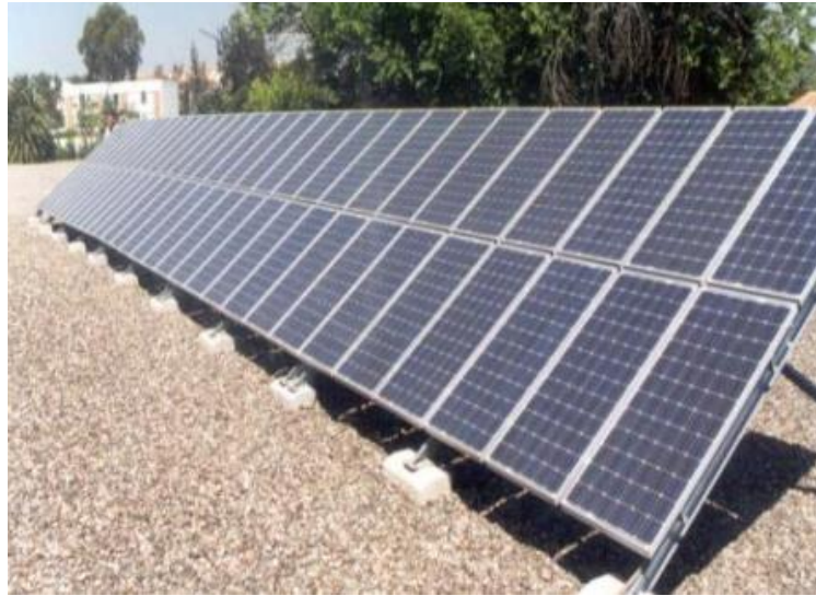
Figura 6. Instalación fotovoltaica aislada [16]
