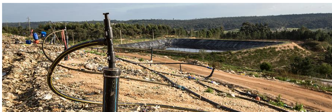
Figura 27. Pozos de captación y conexión para el drenaje del biogás del vertedero hacia la planta de valorización energética. Fuente: (ENC Energy, 2016).
