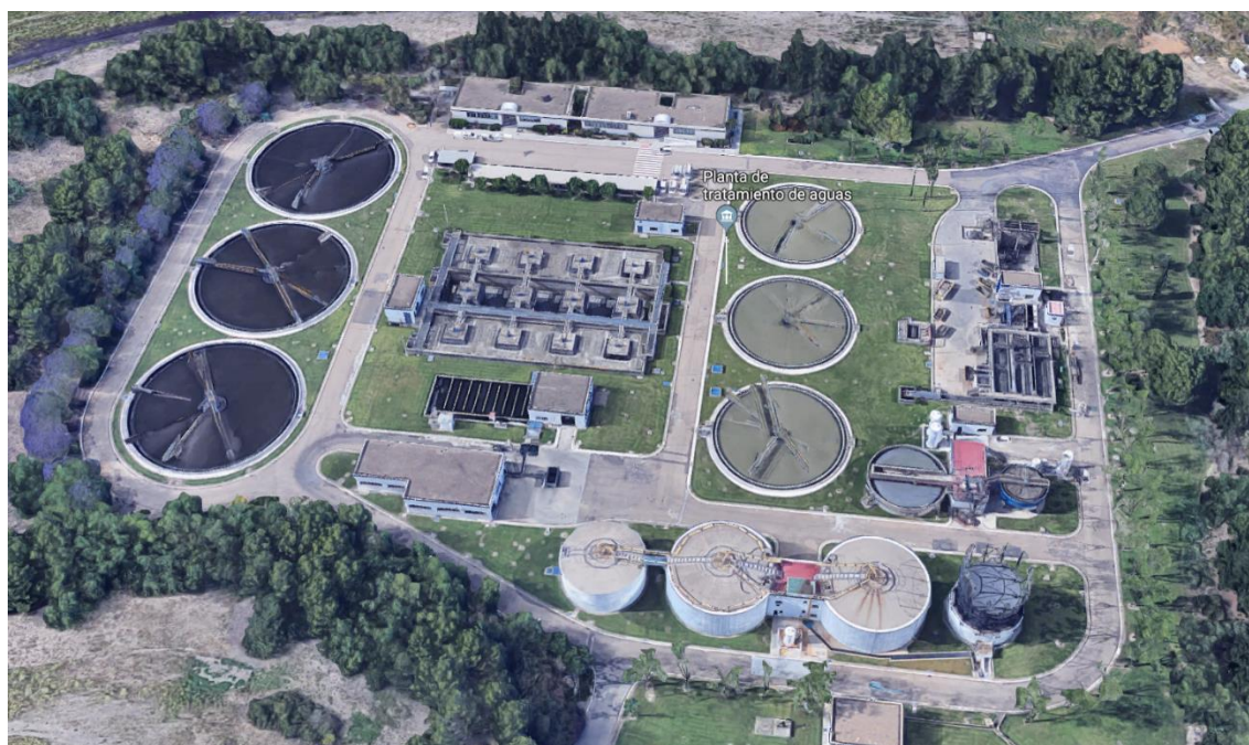
Figura 7. Vista aérea de la EDAR de Tablada. Fuente: Google maps.
