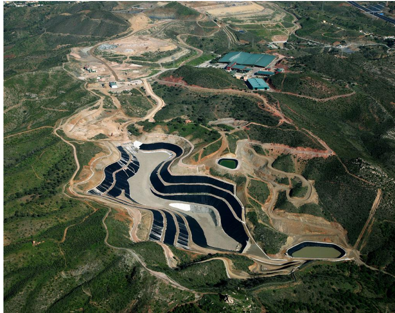
Figura 20. Vertedero controlado en Málaga. Fuente: (Grupotec, 2014).
