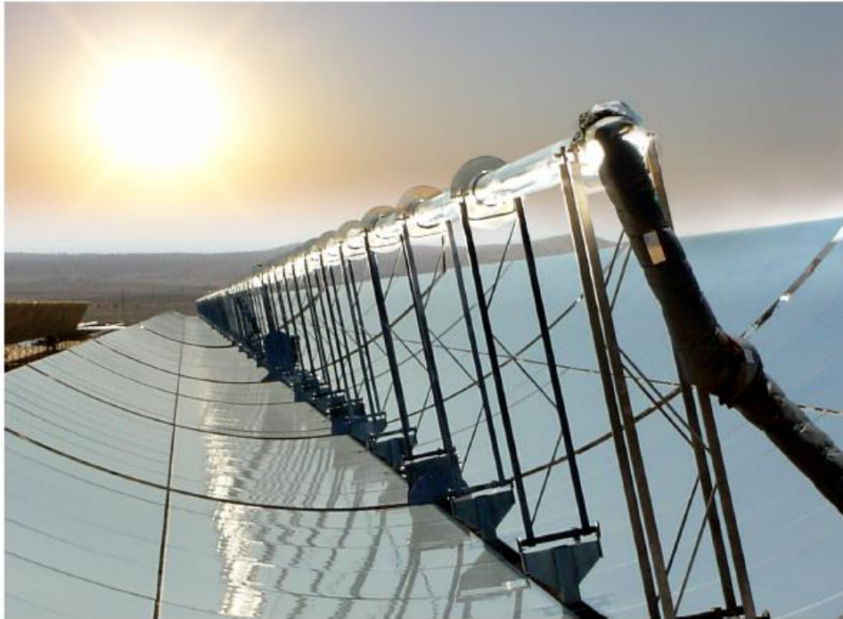
Figura 3-1. Captador cilindro-parabólico (Silva, 2017) [6].
