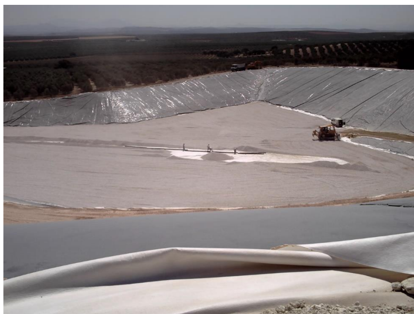
Figura 3-11. Vaso de vertido con impermeabilización (Esquivias, 2014)
