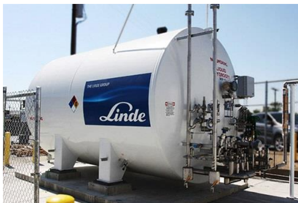
Figura 6-2. Almacenamiento estacionario de hidrógeno líquido [29]
