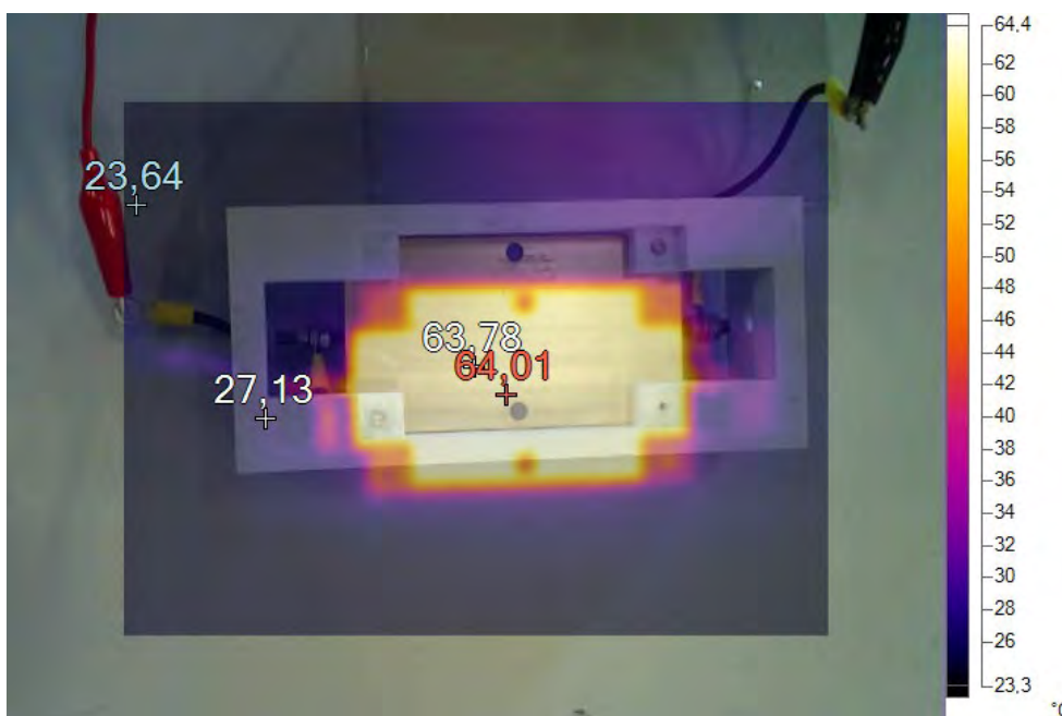
Figura 6-24 Imagen termográfica del bloque visto desde abajo durante la prueba a 25V
