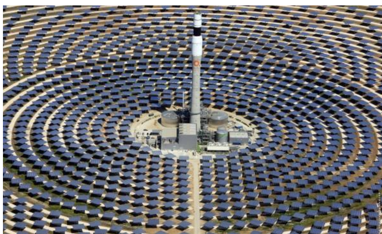
Figura 45. Planta Termosolar de torre. 5
