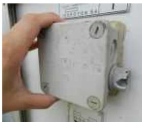
Figura 6: Ejemplo pasatubo en mal estado
