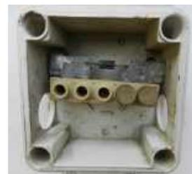
Figura 7: Ejemplo de caja de conexiones con diodo sin pasatubos
