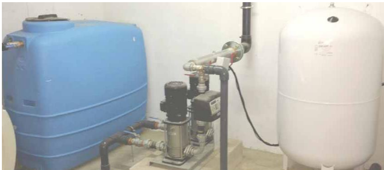
Figura 2-10. Detalle de un grupo de presión donde se observa un depósito acumulador (azul), un depósito de presión (blanco) y dos bombas centrífugas (negro)
