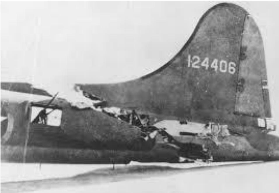
**Figura 2-8.** Graves daños estructurales en un B-17
