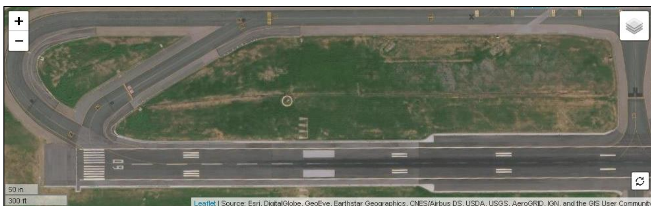
Figura 4-4. Fotografía de la pista con orientación 9 [61].
