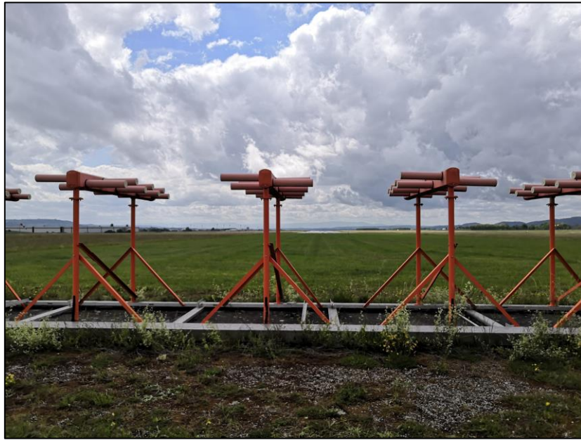
Figura 2-2. Imagen real de un localizador [37].
