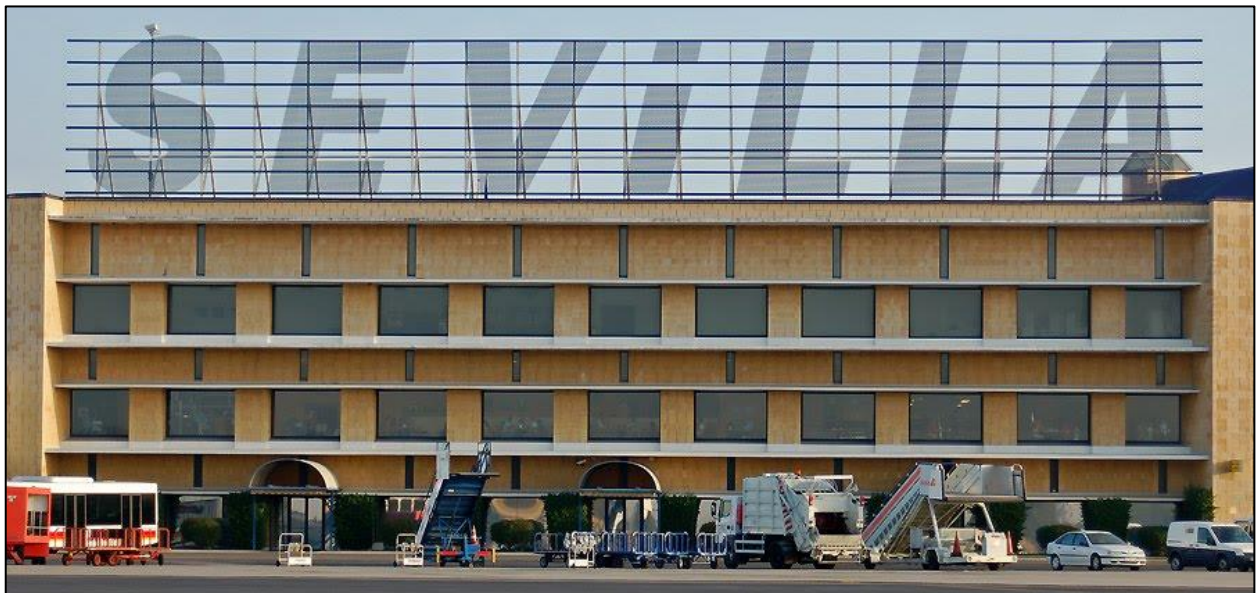
Figura 4-1. Fotografía de una de las entradas a la terminal del aeropuerto de Sevilla [64].
