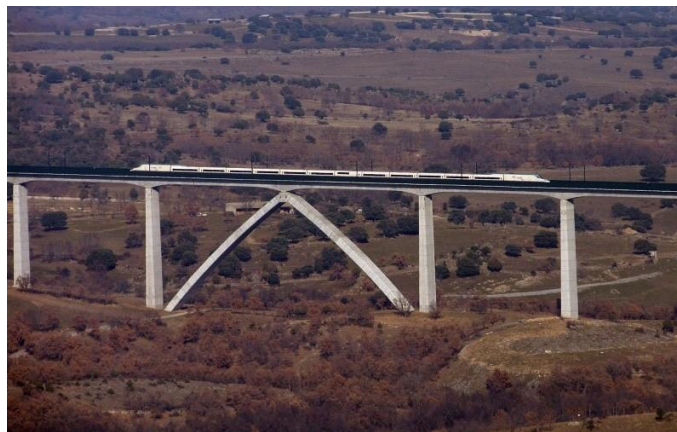
Figura 1. Viaducto Arroyo del Valle perteneciente a la línea Madrid -Valladolid [3].
