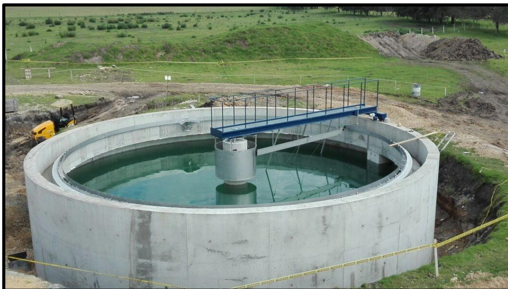
Figura 4. Decantador circular con rasquetas.
