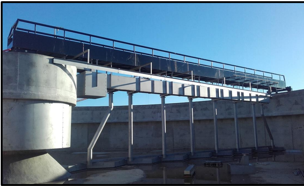
Figura 5. Decantador circular de succión.
