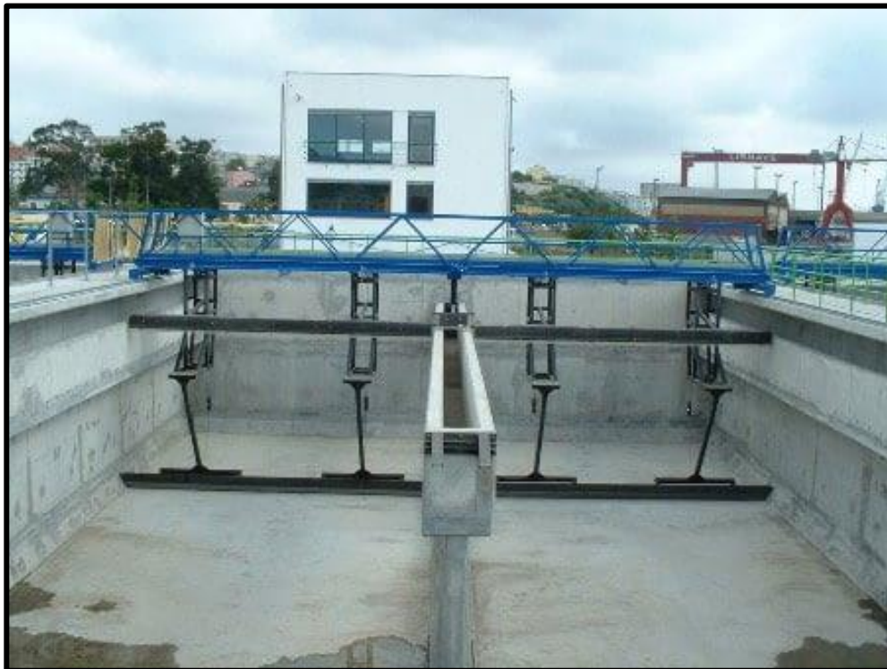
Figura 6. Decantador rectangular.
