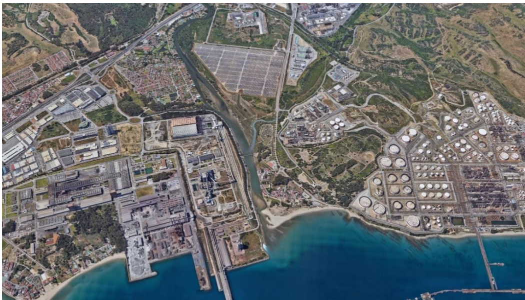
Figura 10. Fotografía aérea de la desembocadura del río Guadarranque.
