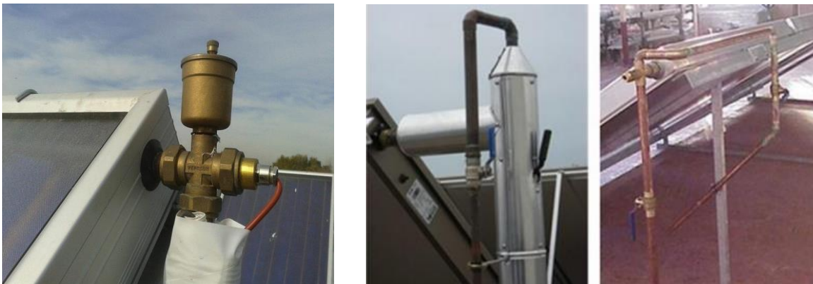
Figura 16 Purgador automático en la salida del captador (Izquierda) y purgadores manuales (centro y derecha)
