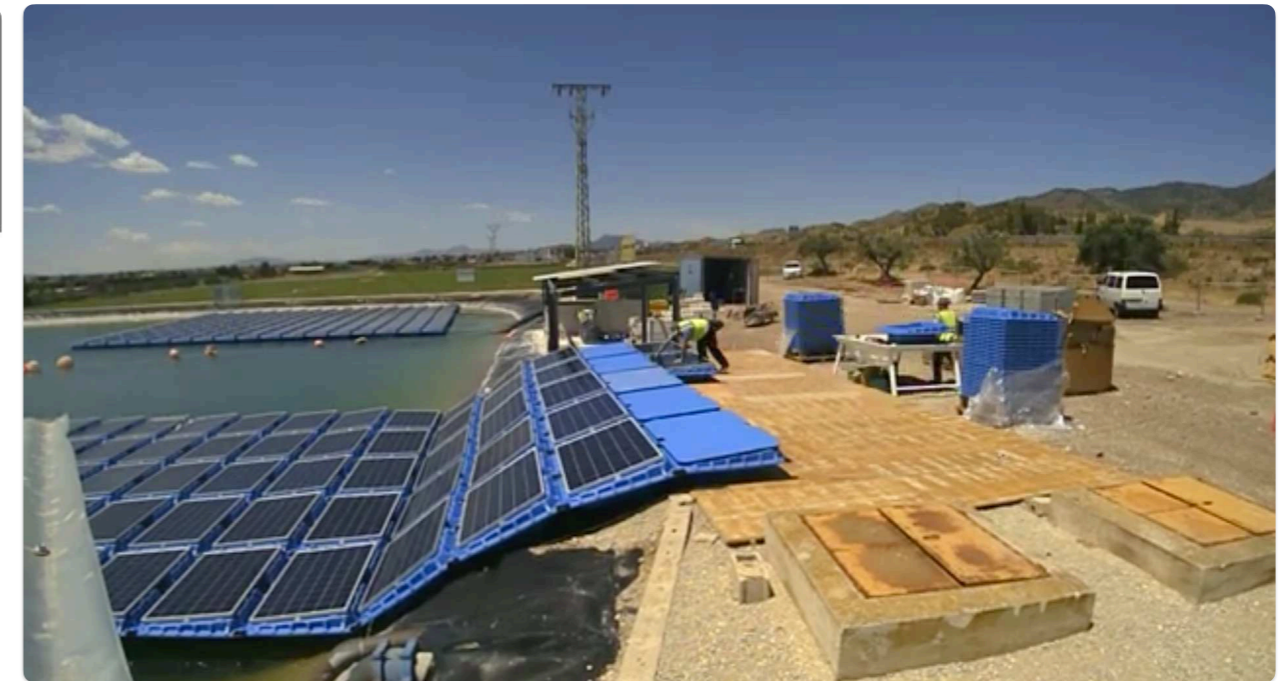
MONTAJE DE LA PLATAFORMA FLOTANTE
