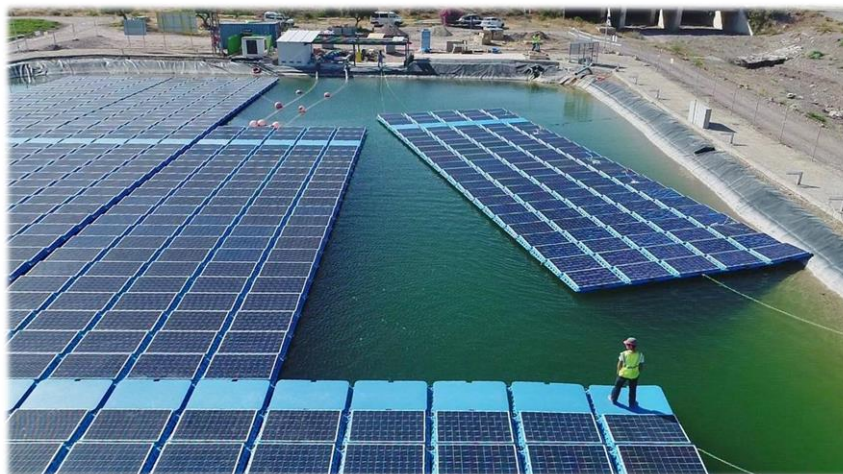
Figura 3: Detalle de operarios montando una instalación de Isigenere. [C]
