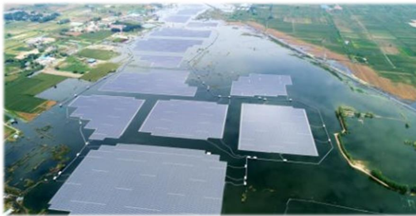
Figura 5: Instalación con sistema de anclaje a orilla, utilizando como orilla un pantalán en Anhui, China. [E]
