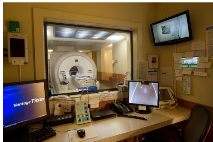
Figura 5. Pantalla de protección en un hospital fabricada a partir de vidrio de plomo. [5]
