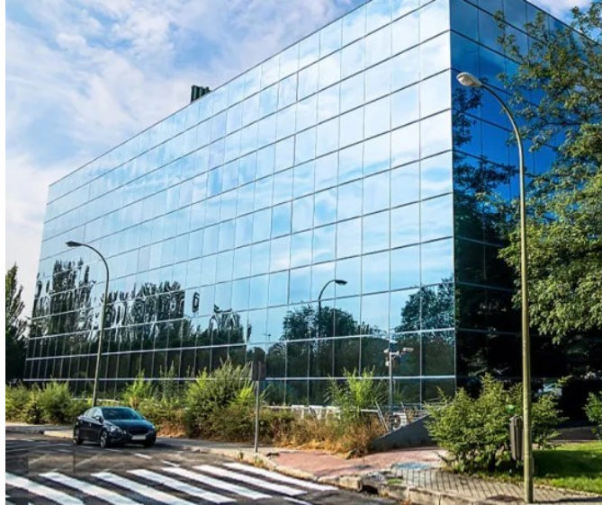
Figura 21. Vidrio reflectante utilizado en la fachada de un edificio en Madrid. [19]
