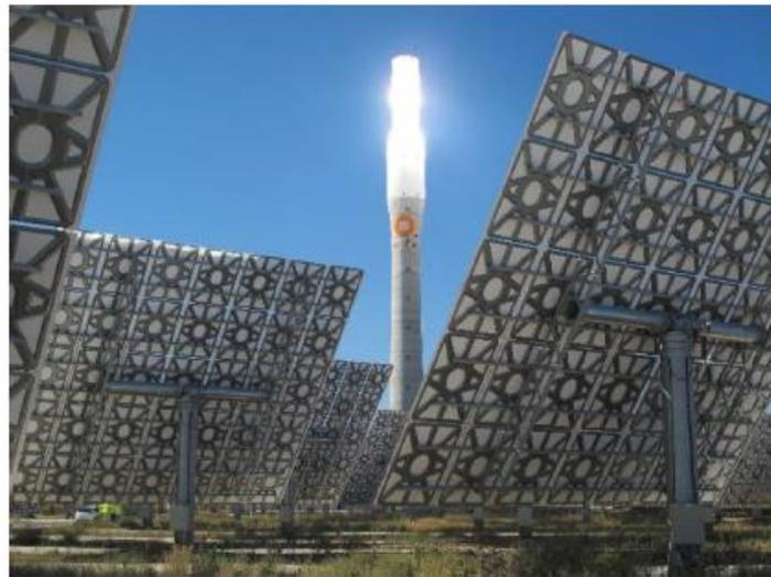
Imagen 16. Heliostatos de la planta Gemasolar [38].
