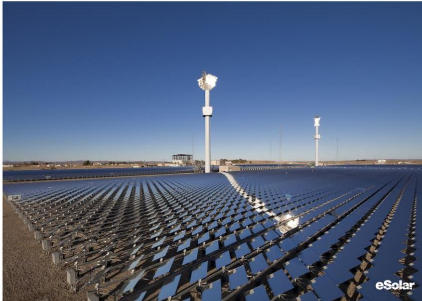
Imagen 9. Heliostatos de  $1.14 \text{ m}^2$  de *eSolar* [16].
