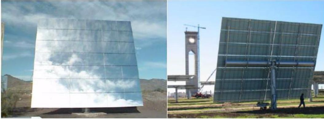
Imagen 15. Heliostatos de las plantas PS10 y PS20 [37].
