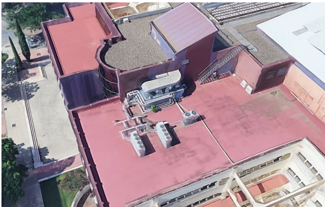
Figura: 4 Cubierta de la Escuela Técnica de Ingeniería
