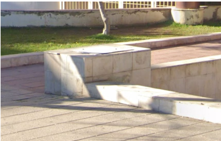
Figura: 26. Arqueta en la esquina de una piscina
