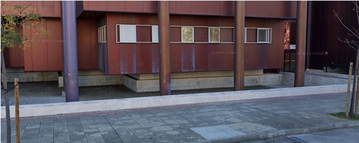
Figura: 15. Estado actual de la piscina noroeste
