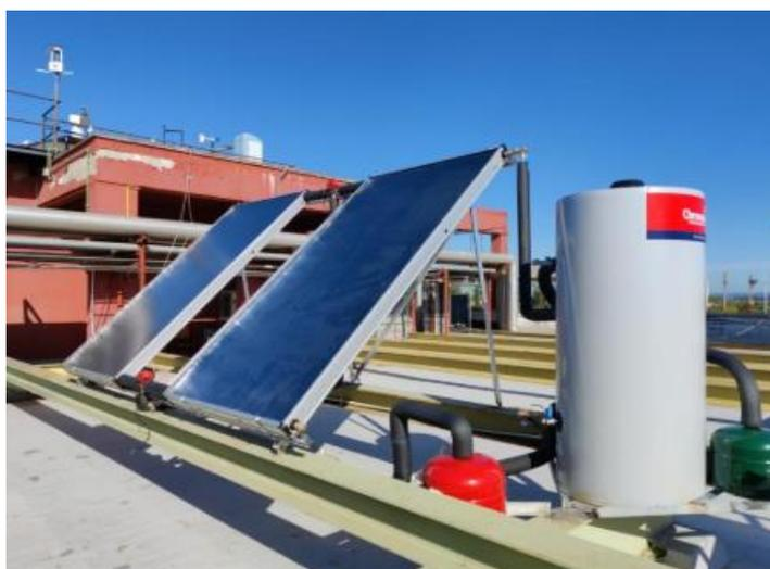
Ilustración 13. Tanque de almacenamiento de ACS junto a los colectores solares
