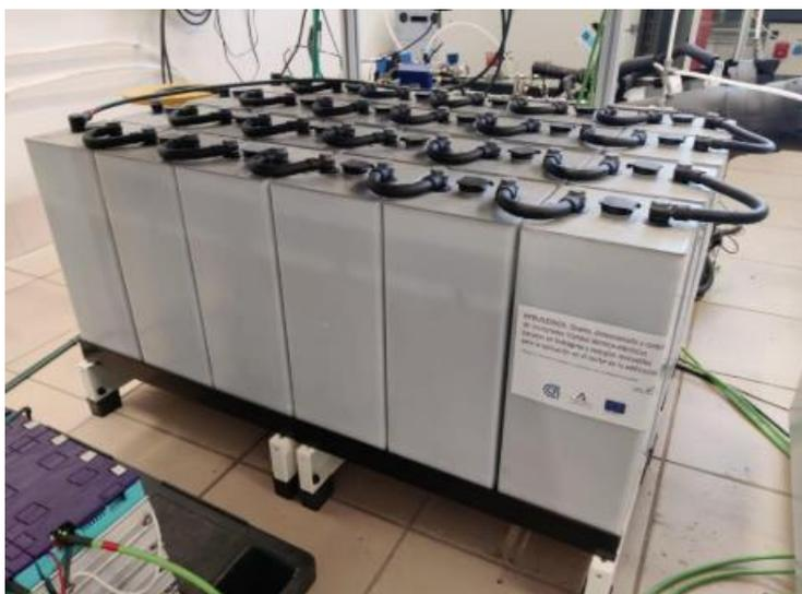
Ilustración 10. Banco de baterías plomo-ácido de la microrred experimental
