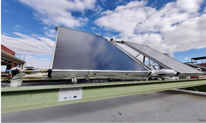
Ilustración 12. Campo solar térmico de la microrred experimental [45]
