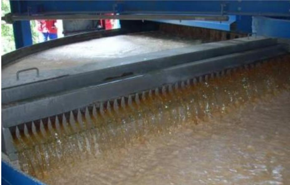
Ilustración 22. Filtro de bandeja operando.
