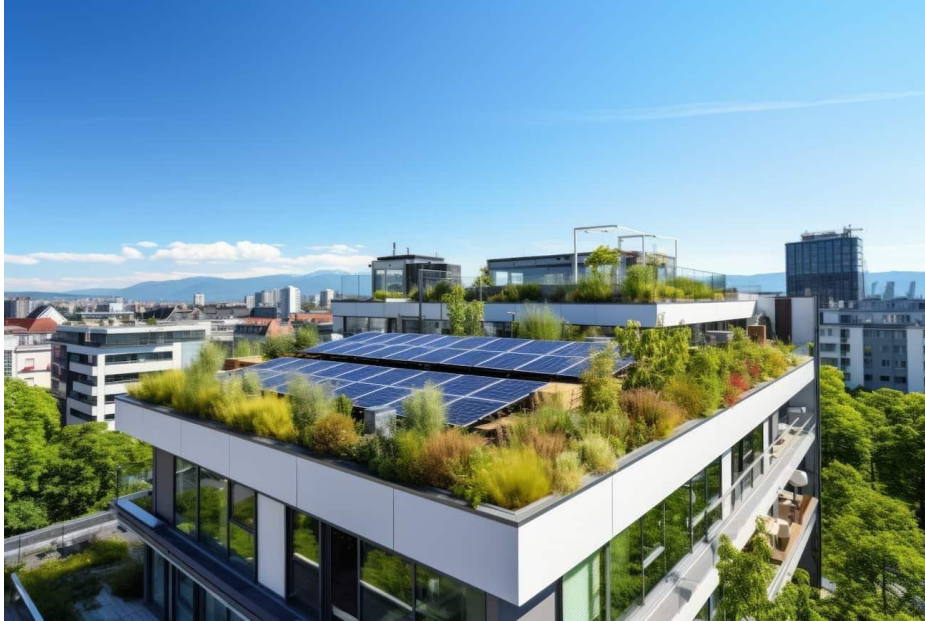
Ilustración 10: Ejemplo de cubierta vegetal en edificio.
