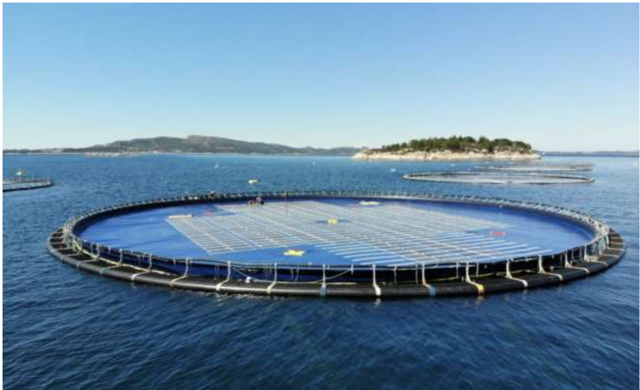
Figura 8. Instalación fotovoltaica flotante de Ocean Sun
