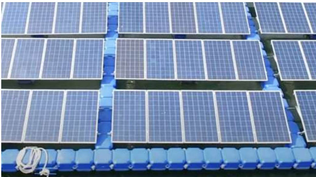
Figura 15. Sistema flotante de Sea Block
