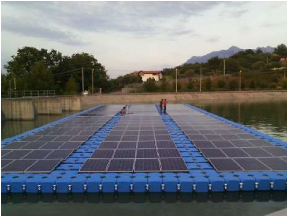
Figura 18. Plataforma de mantenimiento de la instalación
