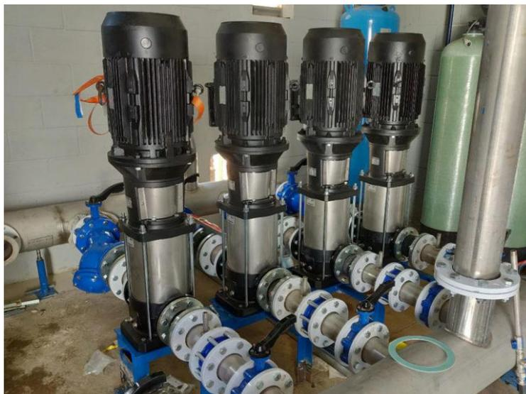
Figura 3-7. Bomba centrífuga eje vertical (Seguas).
