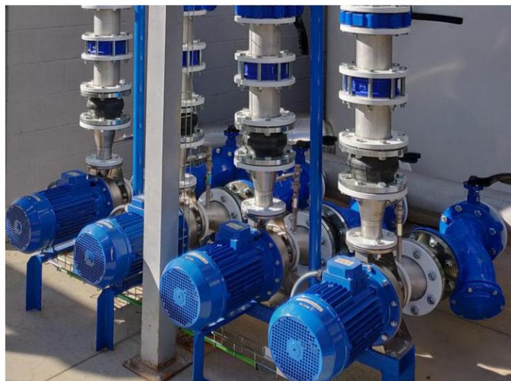
Figura 3-6. Bomba centrífuga eje horizontal (Majerci Sac).
