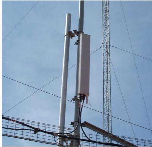
Figura 3.6. Antena UMTS modelo UD02P\_D18BB de Kathrein.
