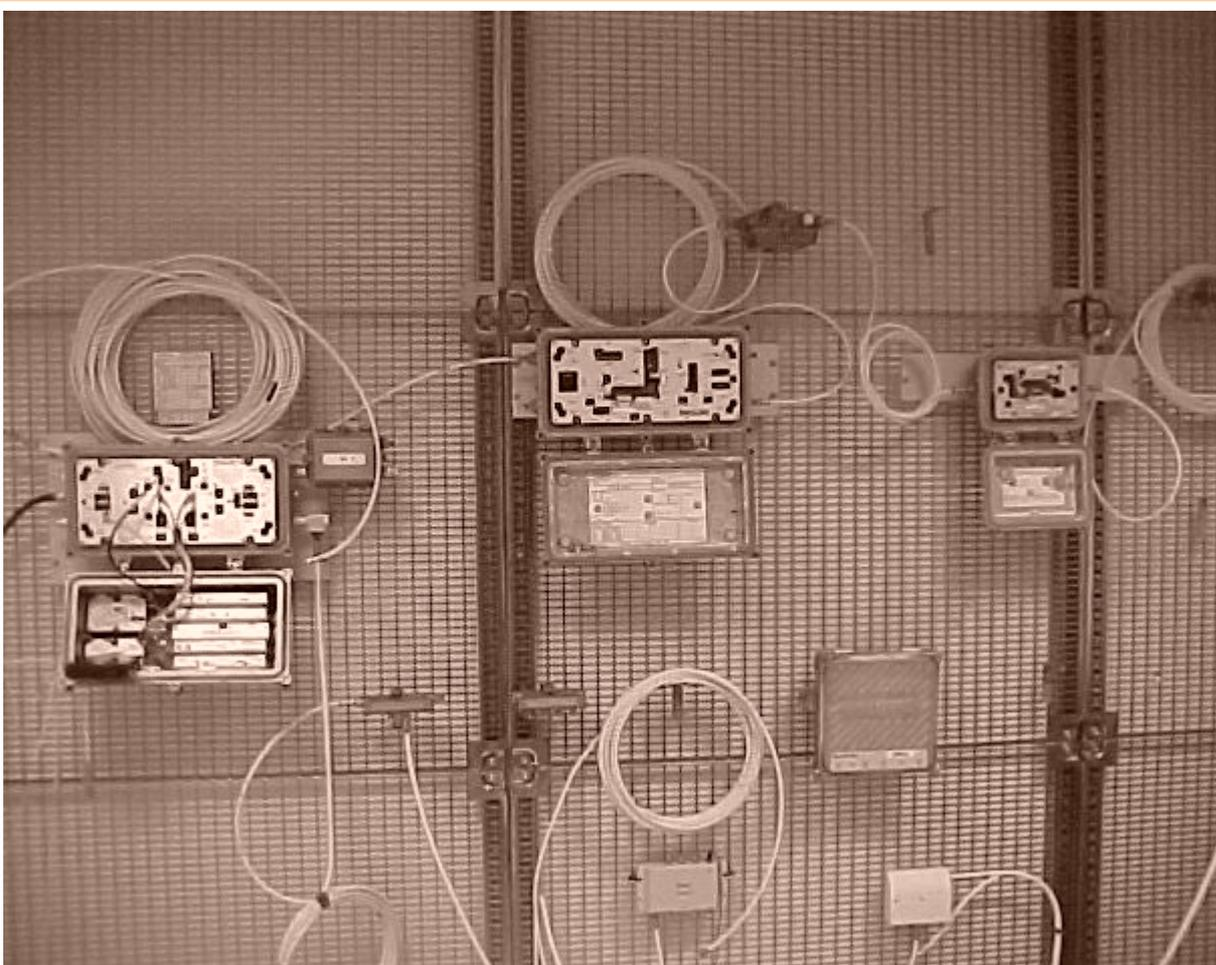
Figura 2.13: Elementos de red de distribución v red de cliente
