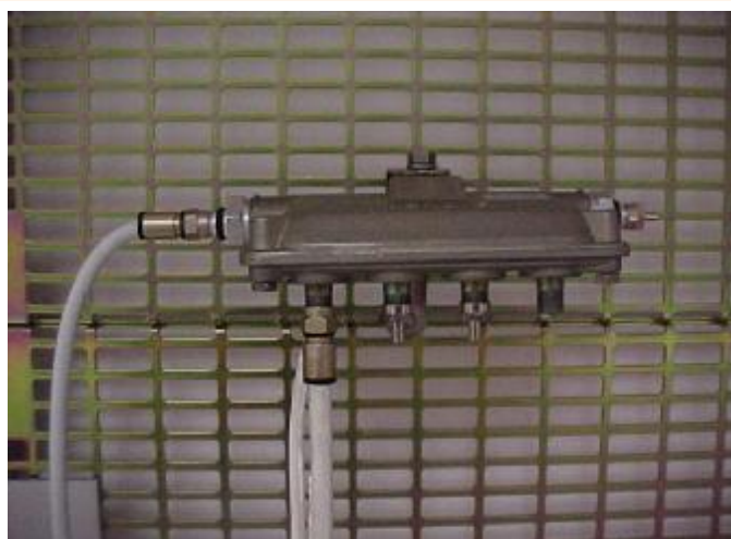
Figura 7.12:TAP 9429 conexión de entrada coaxial Q540, conexión de salida siamés RG6
