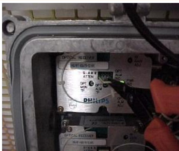
Figura 7.4: Inserción de atenuador
