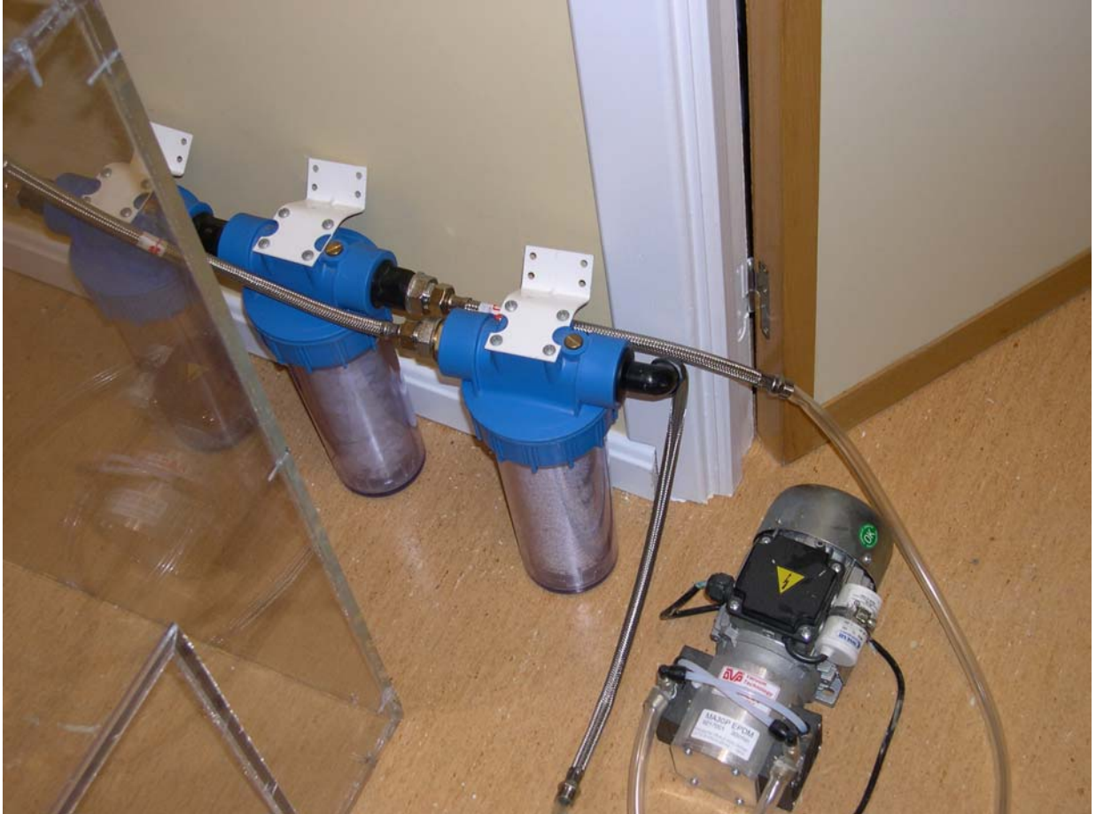
Figura 3.22. Circuito de limpieza del aire
