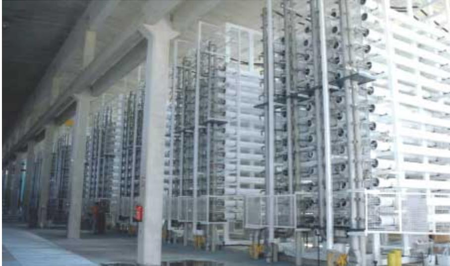
**Figura 6: Bastidores de membranas**
