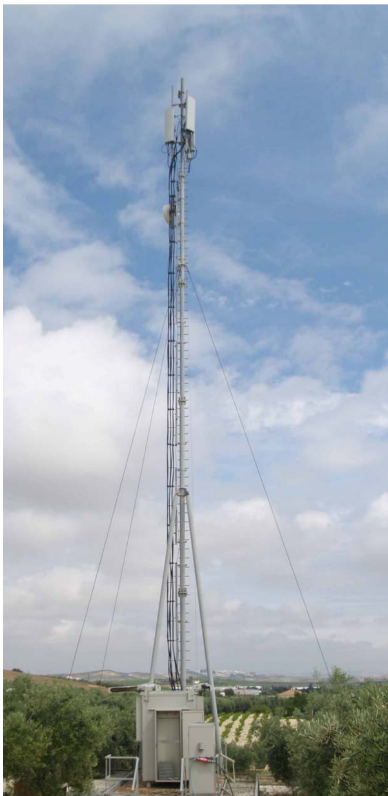
Ilustración 2: ejemplo de torre arriostrada
