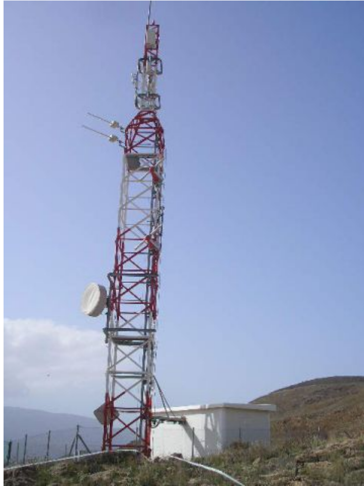
Ilustración 93: Torre de OHANES
