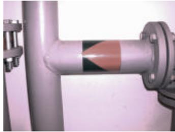
Supone la división de una corriente de entrada en dos de salida. Las características de las dos corrientes de salida vendrán en función de condiciones externas a este elemento.
