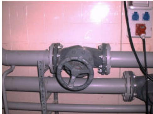
Se ha modelado una válvula estándar de compuerta (de globo, de asiento) con paredes divididas a un ángulo de  $45^\circ$ .
