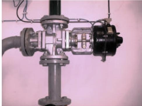
Válvula de tres vías comandada por temperatura, para el ajuste de la temperatura del agua de refrigeración que se suministra a los motores. Esta válvula será utilizada, al igual que el mezclador, para hacer las veces de la refrigeración de un motor con radiador.
