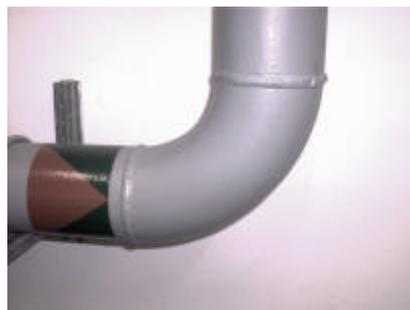
El codo es un elemento geométrico propio de instalaciones de distribución que permite el cambio de dirección en la trayectoria de un fluido.
