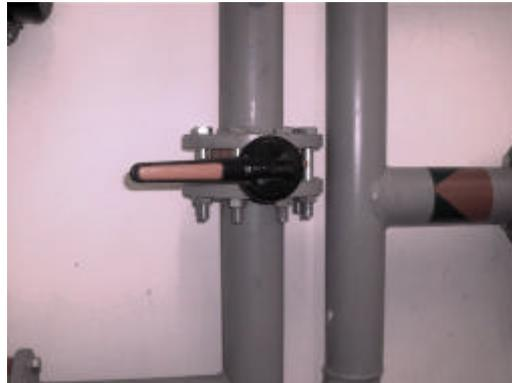
Se trata de modelar un dispositivo destinado a interceptar el paso de un fluido. En este caso se trata de válvulas de mariposa que mediante el giro de una plaquita permiten el paso o no del fluido, en mayor o menor medida en función de las pérdidas de carga que se originen.
