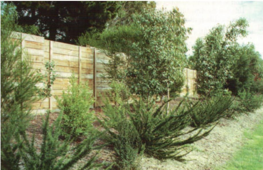
Figura 2.12. Pantalla en madera absorbente (tipo 5c, cuadro 2.8). Austria:
