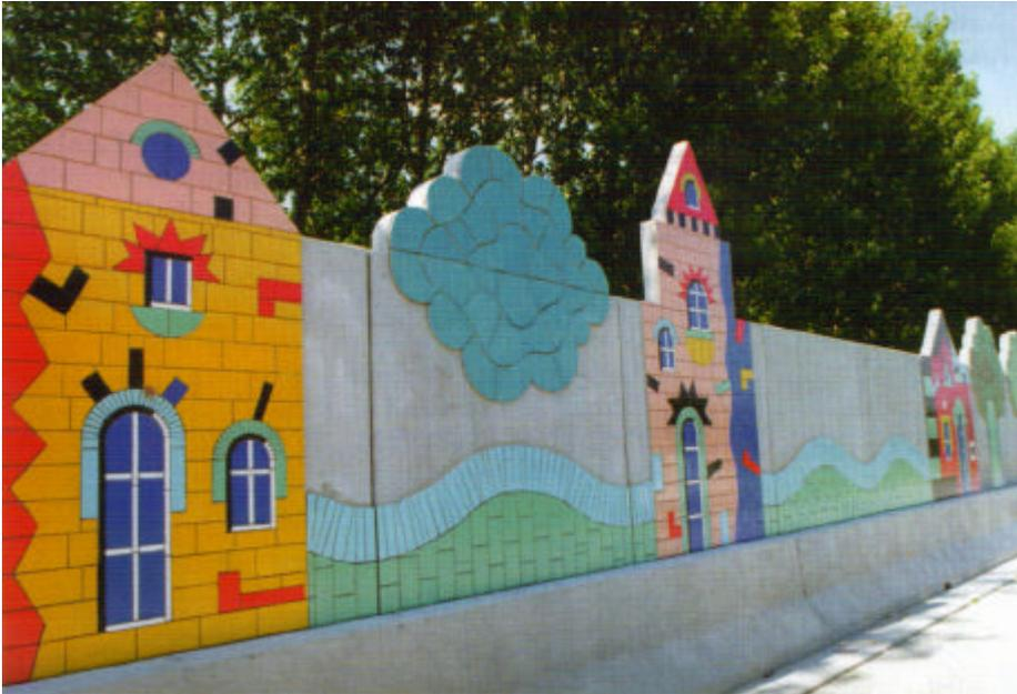
Figura 2.14. Pantalla reflectante integrada al paisaje gracias a la utilización de elementos transparentes y de arreglos paisajísticos. (tipo 5, cuadro 2.8). Austria:
