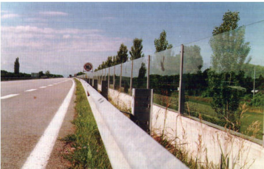
Figura 2.15. Pantalla reflectante antirruído en vidrio (tipo 8 y 5f, cuadro 2.8).
