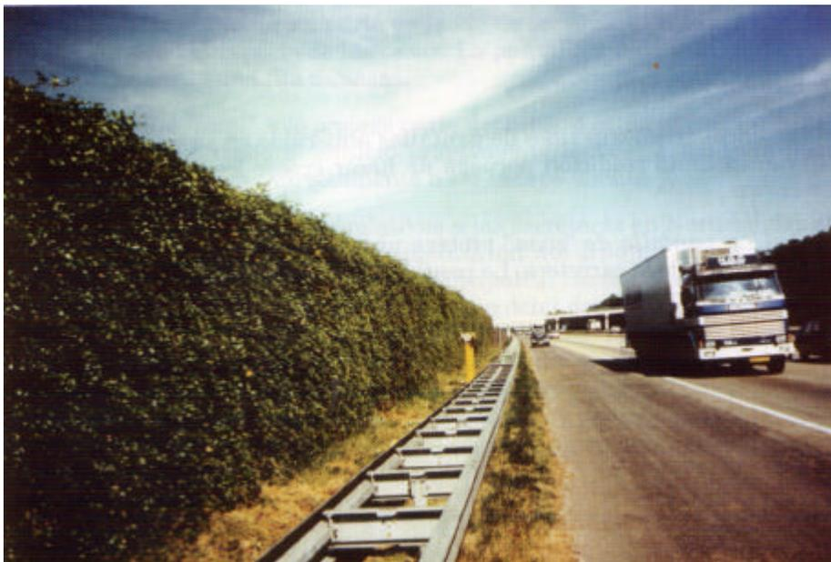
Figura 2.18. Pantalla de hormigón de absorción alta (absorbente)(tipo 5b, cuadro 2.8). Países Bajos:
