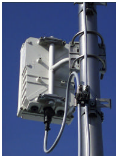
Figura 4-6 Vista del montaje de la PRU en poste o mástil
