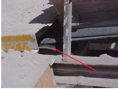
Fotografía nº 33 – CINTA/TC-17. Resguardo de protección insuficiente.
