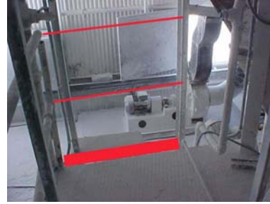
Fotografía nº 26 – ELEVADOR/EC-2013. Faltan barandillas.
