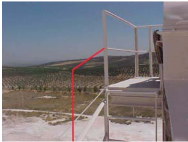
Fotografía nº 81 – ELEVADOR/EC-2101. Elevar barandilla al lado de escalera.
