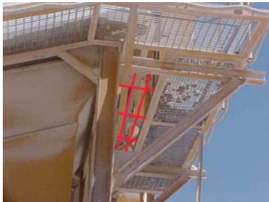
Fotografía nº 21 – CRIBA/CV-11. Huevo en la plataforma de acceso.
