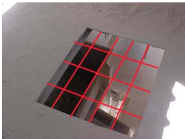
Fotografía nº 21 – CINTA/TC-161. Cubrir hueco en la plataforma de acceso.
