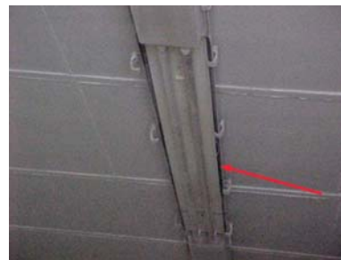
Fotografía nº 4 – C. HIDRÁULICA/CH1-H4. Reparar luz estancia.
