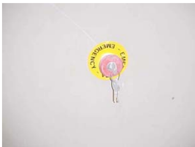
Fotografía nº 3 – CUADRO DE MANDO. Señalizar en castellano e identificar equipos a los que pertenece.
