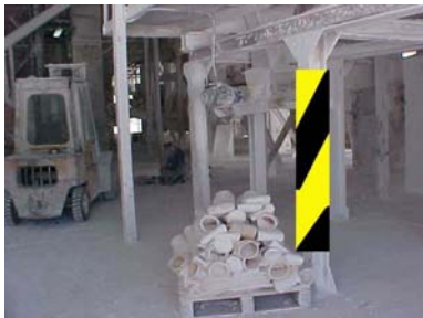
Fotografía nº 35 – SEPARADOR/SE-2015. Señalizar columnas para el paso de carretillas.
