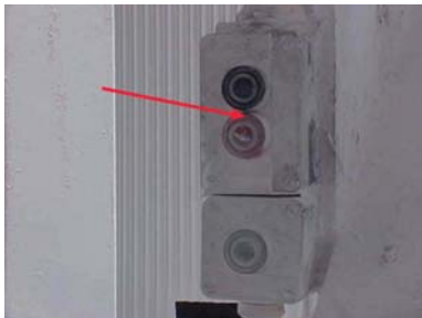
Fotografía nº 75 – SINFÍN/SF-23. Accionamientos sin identificar
