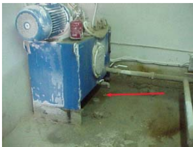
Fotografía nº 3 – C. HIDRÁULICA/CH1-H4. Instalar bandeja colectora de líquidos.
