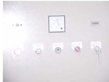
Fotografía nº 2 – CUADRO DE MANDO. Órganos de accionamiento en desuso dan motivo a confusión.
