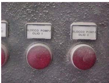
Fotografía nº 7 – CALDERA IVAR ODE. Señalizar los órganos de accionamiento en castellano.
