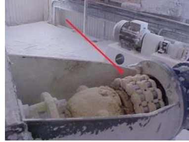
Fotografía nº 10 – SINFÍN/SF-2006. Falta resguardo de protección.
