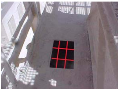
Fotografía nº 29 – CRIBA/CV-104. Cubrir hueco en la plataforma.
