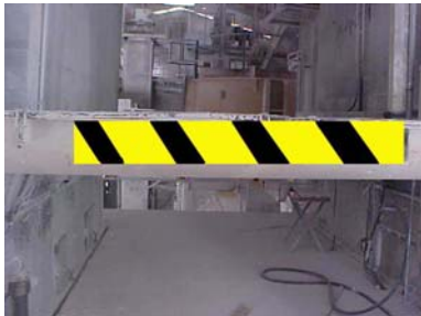
Fotografía nº 13 – SINFÍN/SF-2007. Falta señalización de golpeo.
