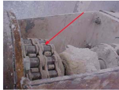
Fotografía nº 12 – SINFÍN/SF-2007. Falta resguardo de protección.
