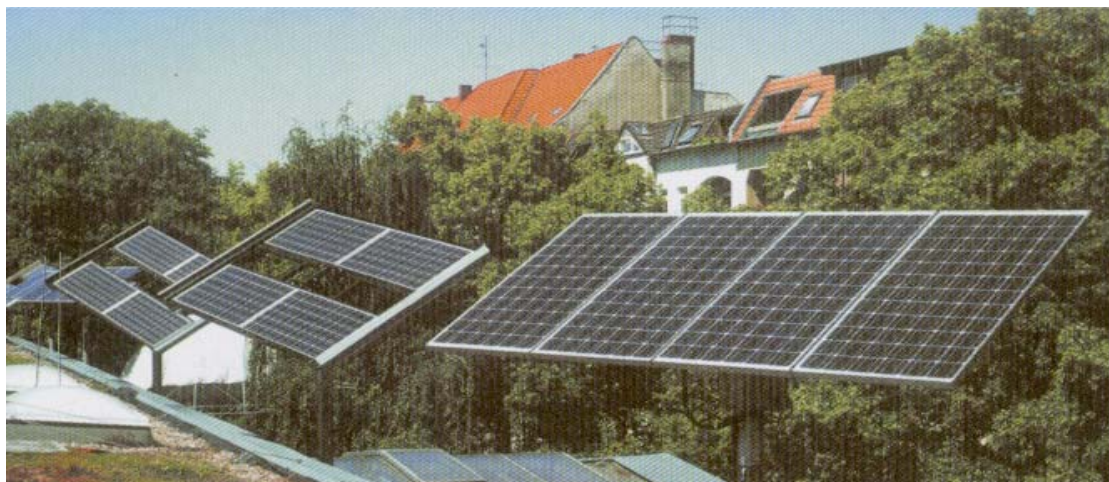
Figura 1.2.8. Ejemplo de placas solares con dispositivo de seguimiento Fuente: Instalaciones F.V. Manual para uso de instaladores, fabricantes, proyectistas, ingenieros y arquitectos, instituciones de enseñanza y de investigación. Dirección General de Industria, Energía y Minas.
