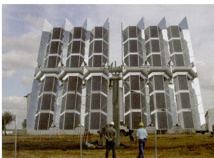
Figura 2.5.0.1. Seguidores de dos ejes con concentradores. Fuente: nota al pie*
