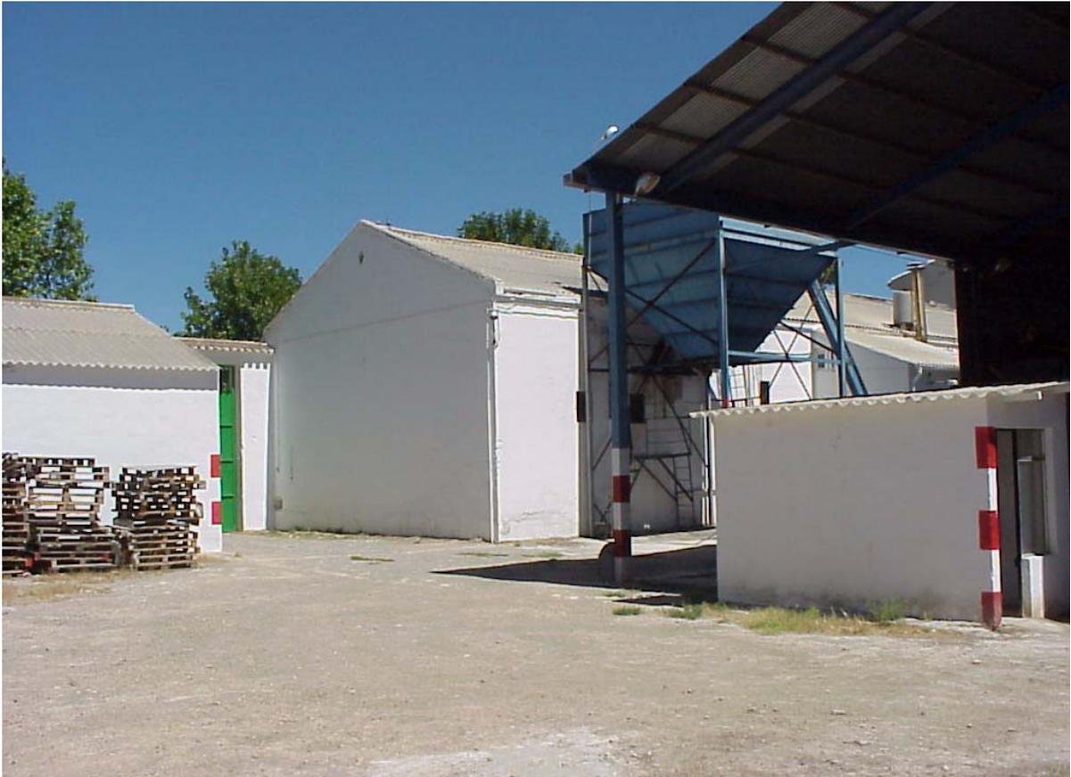
Como se puede apreciar en la fotografía este espacio no está cubierto y el solado está compuesto por tierra y canto rodado. También se aprecia la tolva de almacenamiento de orujo que se encuentra a la derecha de la entrada. Hay que destacar la presencia de una báscula puente para pesado de camiones. Esta parte del patio también hace de distribuidor, dando acceso a las demás estancias.
