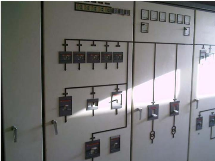
barras estarán conectadas de la manera que se especifica dentro del plano de Esquema de Principio. Esta manera es tal que siempre funcione la red y en caso de fallo de suministro, para hacer que haya corte breve en aquellas zonas que así lo requieren entrará en funcionamiento una batería de condensadores a la que llamaremos a partir de
