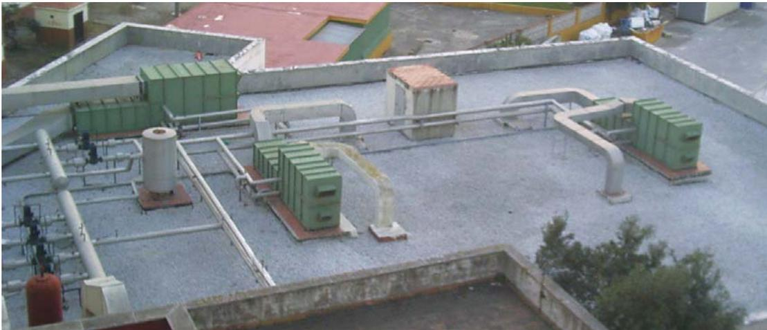
Tanto las enfriadoras mostradas con anterioridad como estos intercambiadores tienen la altura de una persona. Por eso son colocadas en las plantas altas y azoteas de los edificios tal y como se detalla en el plano de "principio de la instalación", y se corrobora a la hora de poner la longitud de dichos cables conductores que los alimentan.
