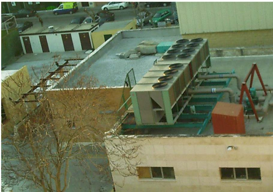
A partir de aquí, habrá una red de tuberías por las que circulará el fluido refrigerante hasta unos intercambiadores para enfriar el aire. Estos aparatos son voluminosos por el proceso de intercambio, pero apenas consumen potencia debido a que el único aporte que necesitan es el de las
