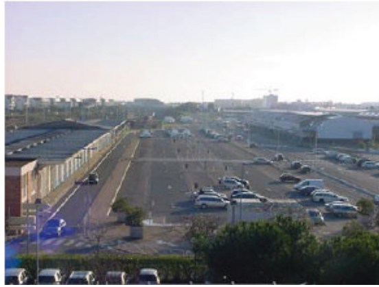
Ilustración 2: Estado actual de la zona donde se construirá el barrio Oeste
